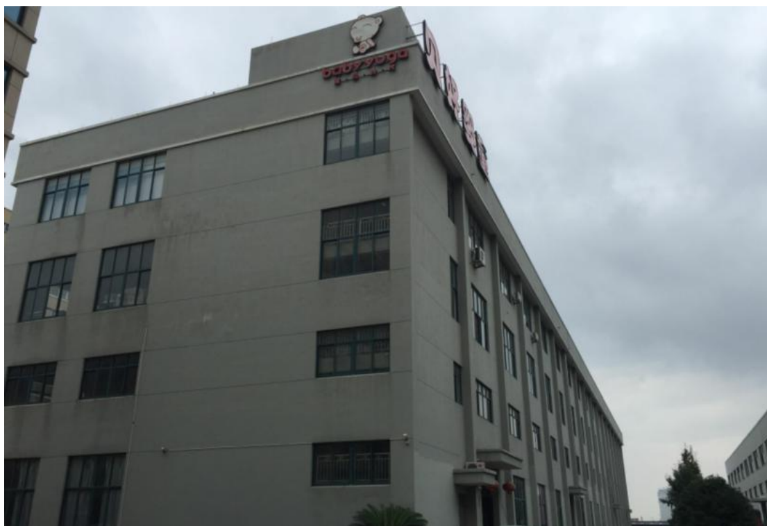
厂区生产车间
